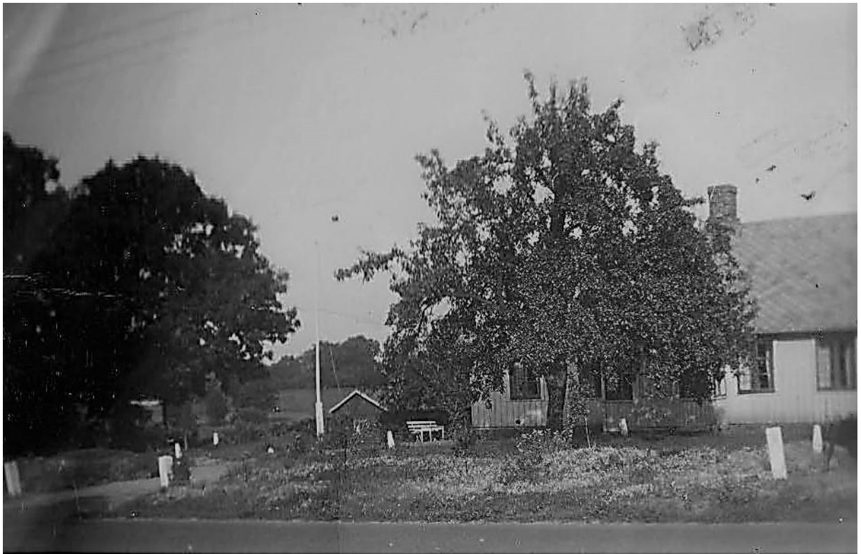
Nu är verandan ombyggd och inglasad, plåt tak. 40-50 talet.
