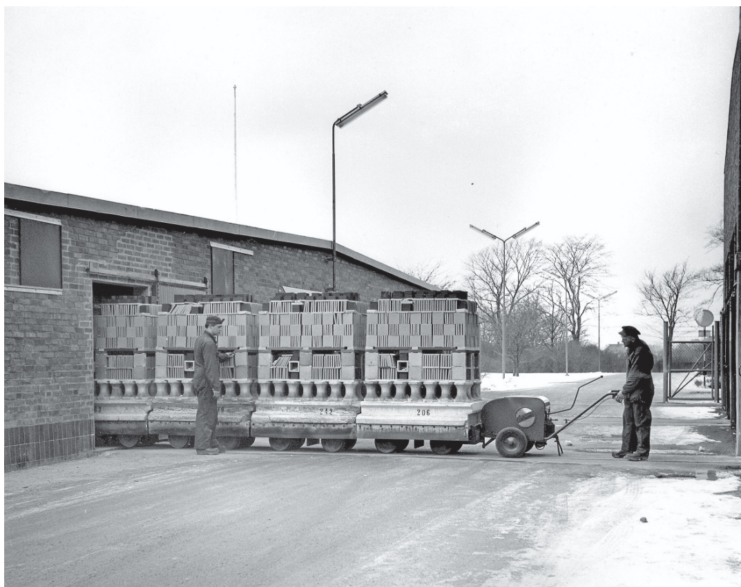
Tunnelgnsvagnar lastade med klinker körs till sortering.
