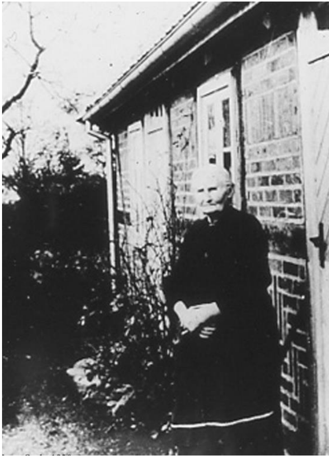
Foto 1930 utanför bostaden, ”Torstenssonska huset”.
